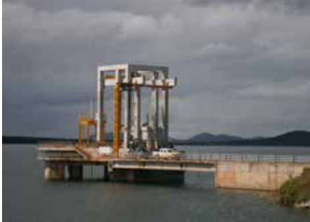
Gove dam, Huambo.
